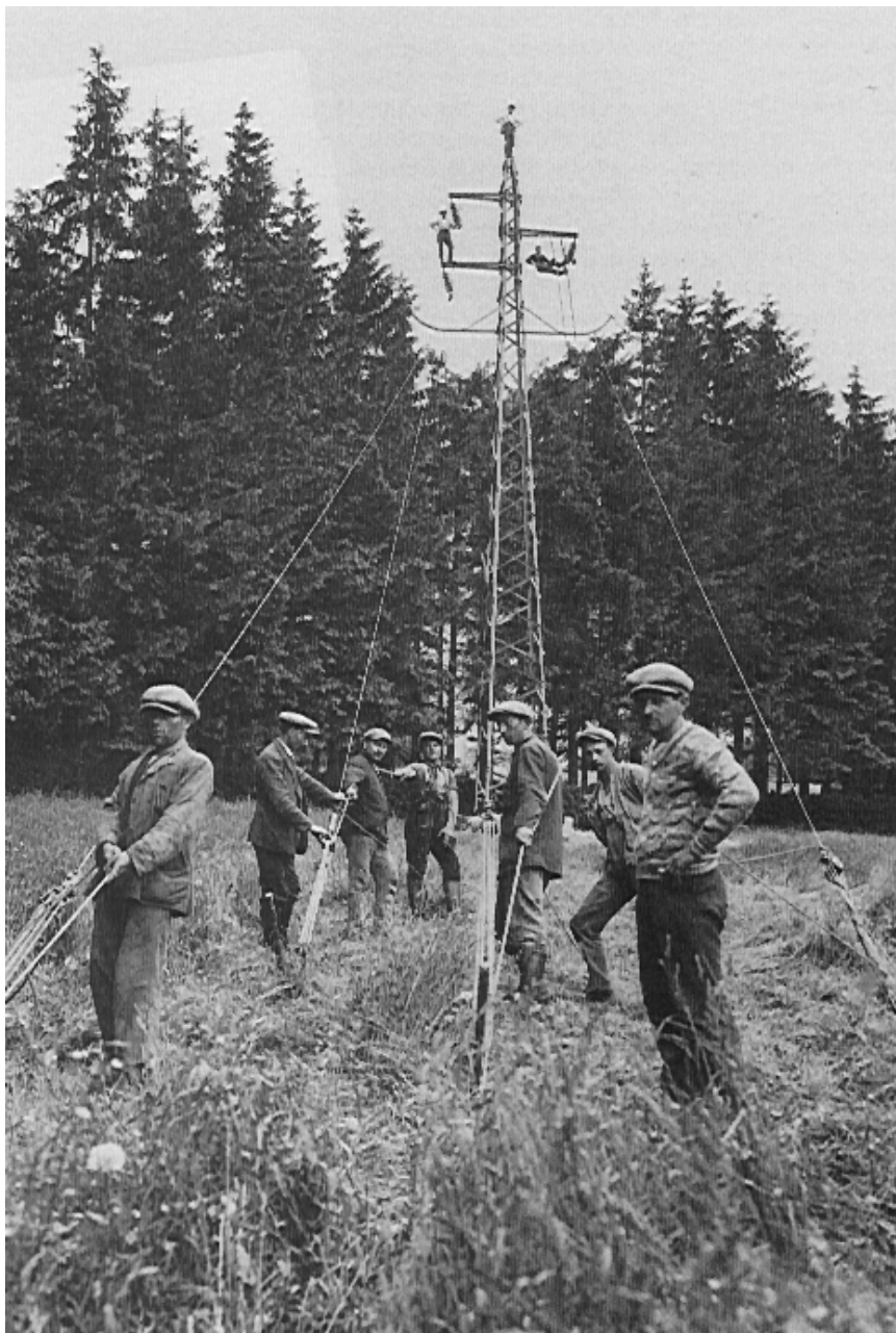
Fig. 1 Hoogspanningslijn op 70 kV ca.1930 (bron Tractebel)
