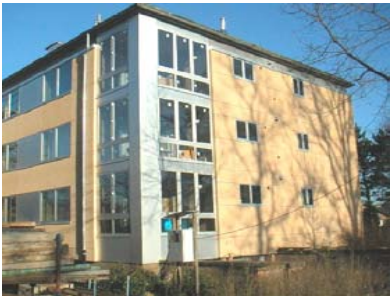
Energierenovatie van een sociale woonwijk te Vorselaar resulterend in een daling van de totale warmtevraag met 70% na renovatie
