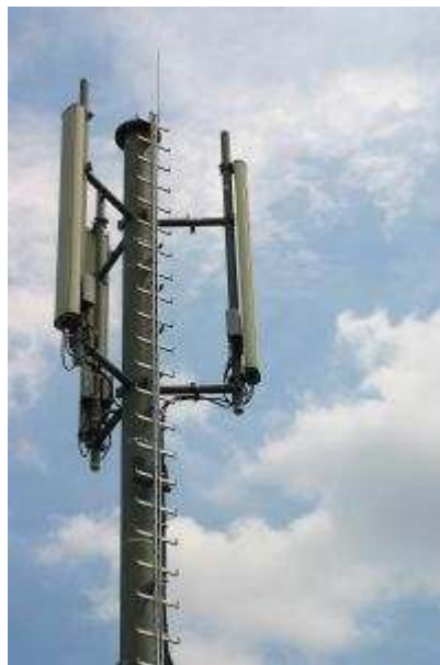
Figuur 8: Mast met verschillende basisstations en antennes.
